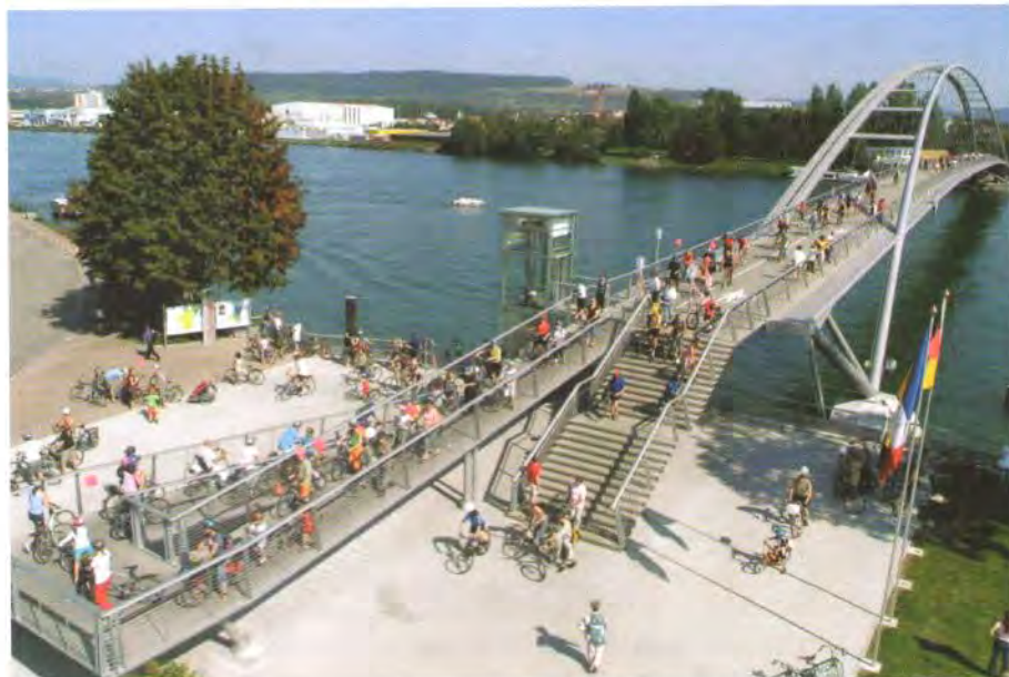
Oblúbený nemecko-francúzsky most „Dreiländerbrücke“ od architekta Dietmara Feichtingera
